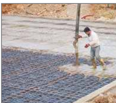
Proces zalewania betonem
