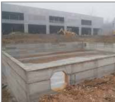
Wylana płyta fundamentowa i ściany obwodowe oraz ustalone otwory wpustowe/wypustowe
