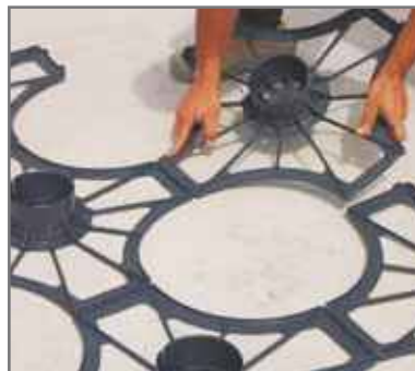
Układanie ELEVATOR® BASE
