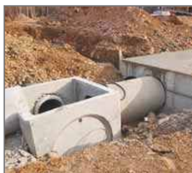
Instalacja betonowych rur
