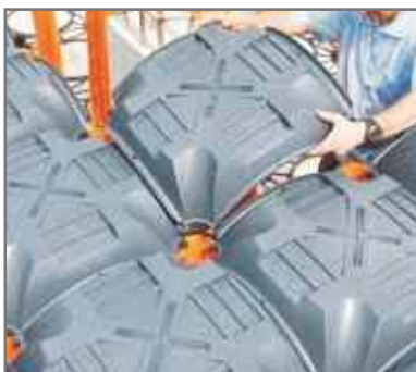
Instalacja ELEVATOR® FORMWORK
