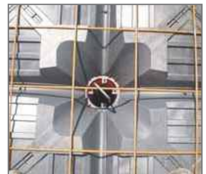
Umieszczenie siatki zbrojeniowej i prętów w rurach PCV
