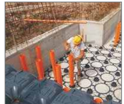
Umieszczanie rur PVC
